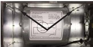
DK2 TABS MUST BE INSERTED IN AS2 BLOWER CABINET.
